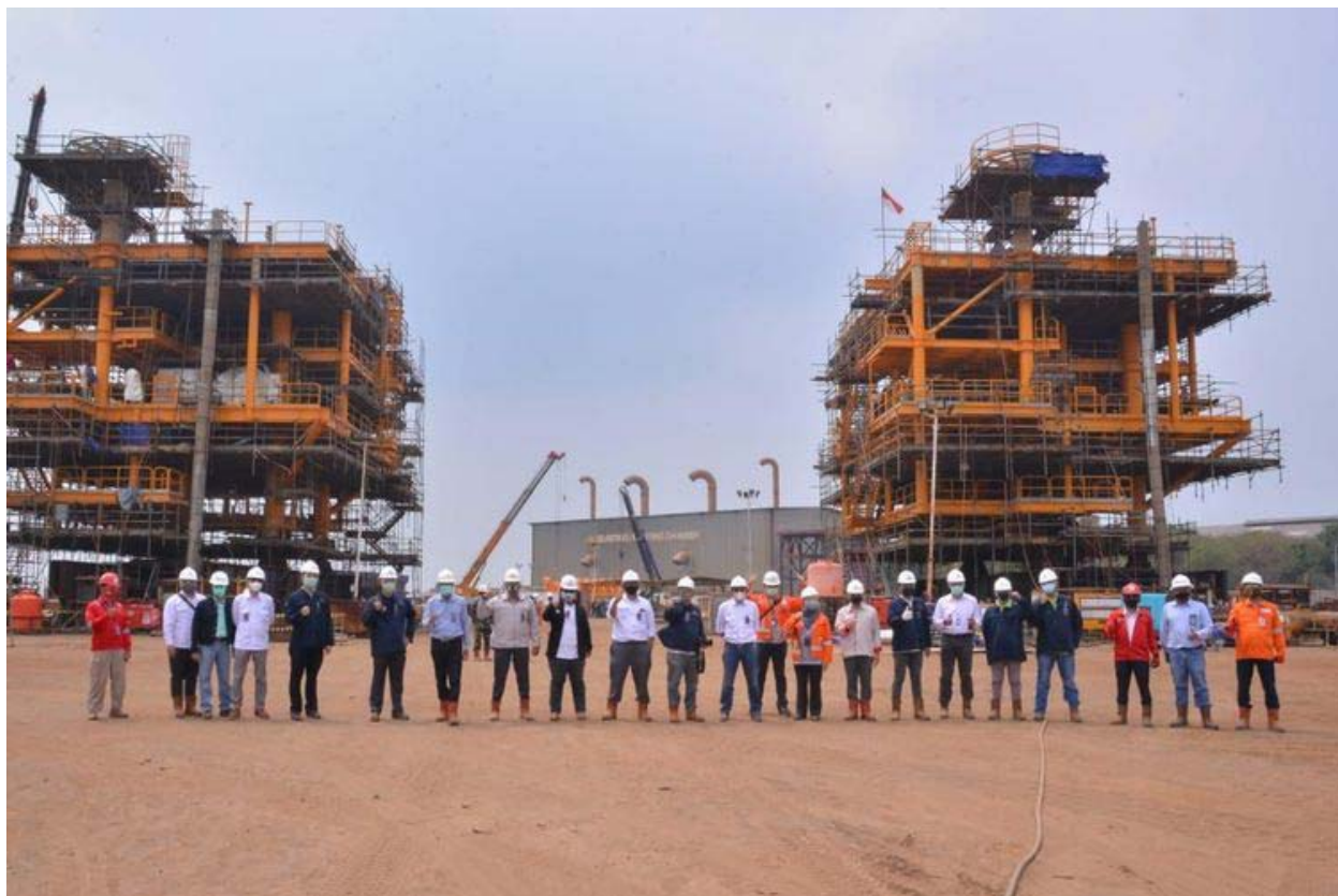
Progress pembangunan Platform Lapangan Sidayu di Cilegon, WHPC dan WHPD.(DOK. Humas PGN)
