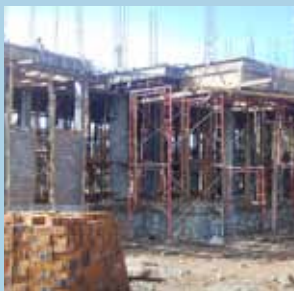
Pembangunan masjid Februari 2010
